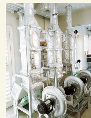
れいだんぼう 地下水・温泉水冷暖房装置
